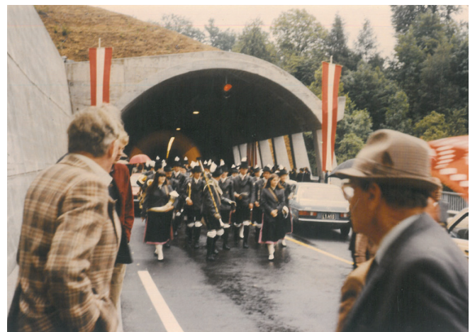
1984 - Eröffnung des Kaiserparktunnels
